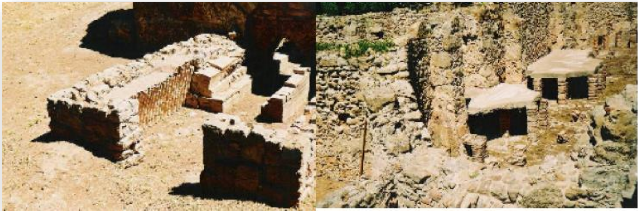
Slika 2.2 Podno grijanje na Siciliji u 1. stoljeću, [1].
