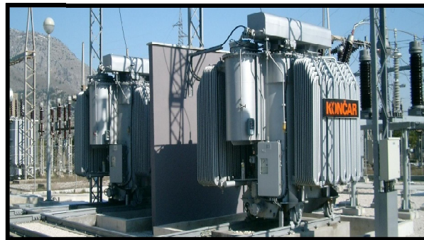
Slika 2.8. Primjer izvedbe energetskeg transformatora firme Končar – energetske transformatori [43]
