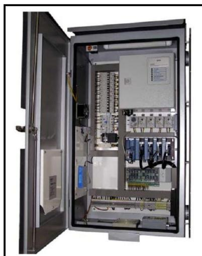
**Slika 8.2.** Razvodni ormar sustava motrenja Končar - TMS [76]
