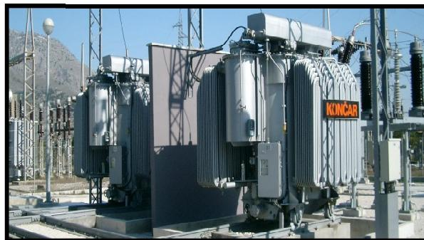
**Slika 2.8.** Primjer izvedbe energetskog transformatora firme Končar – energetski transformatori [43]
