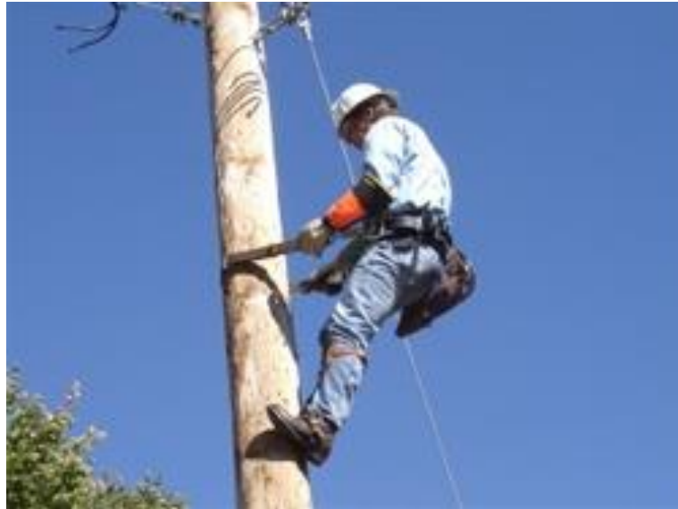
Sl. 5.5. Oprema za pozicioniranje montera [20].
