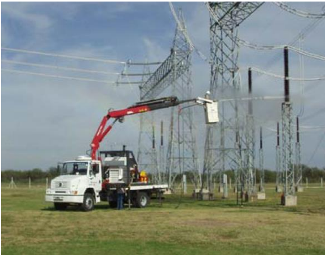
Sl. 3.12. Pranje izolatora s autoplatforme [5].
