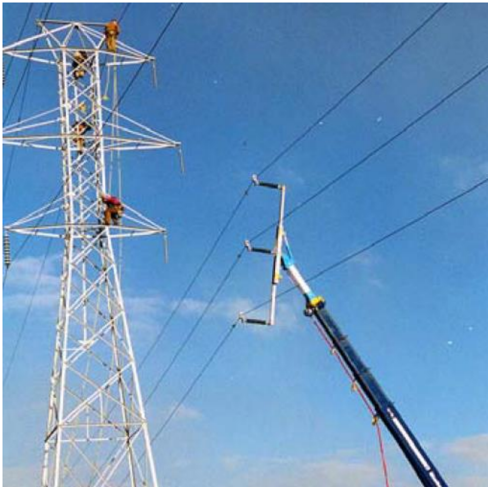
Sl. 3.8. Primjer sve tri faze ovješene na robotsku ruku [5].
