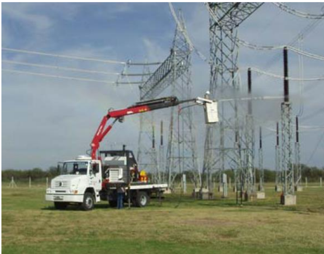
Sl. 3.12. Pranje izolatora s autoplatforme [5].
