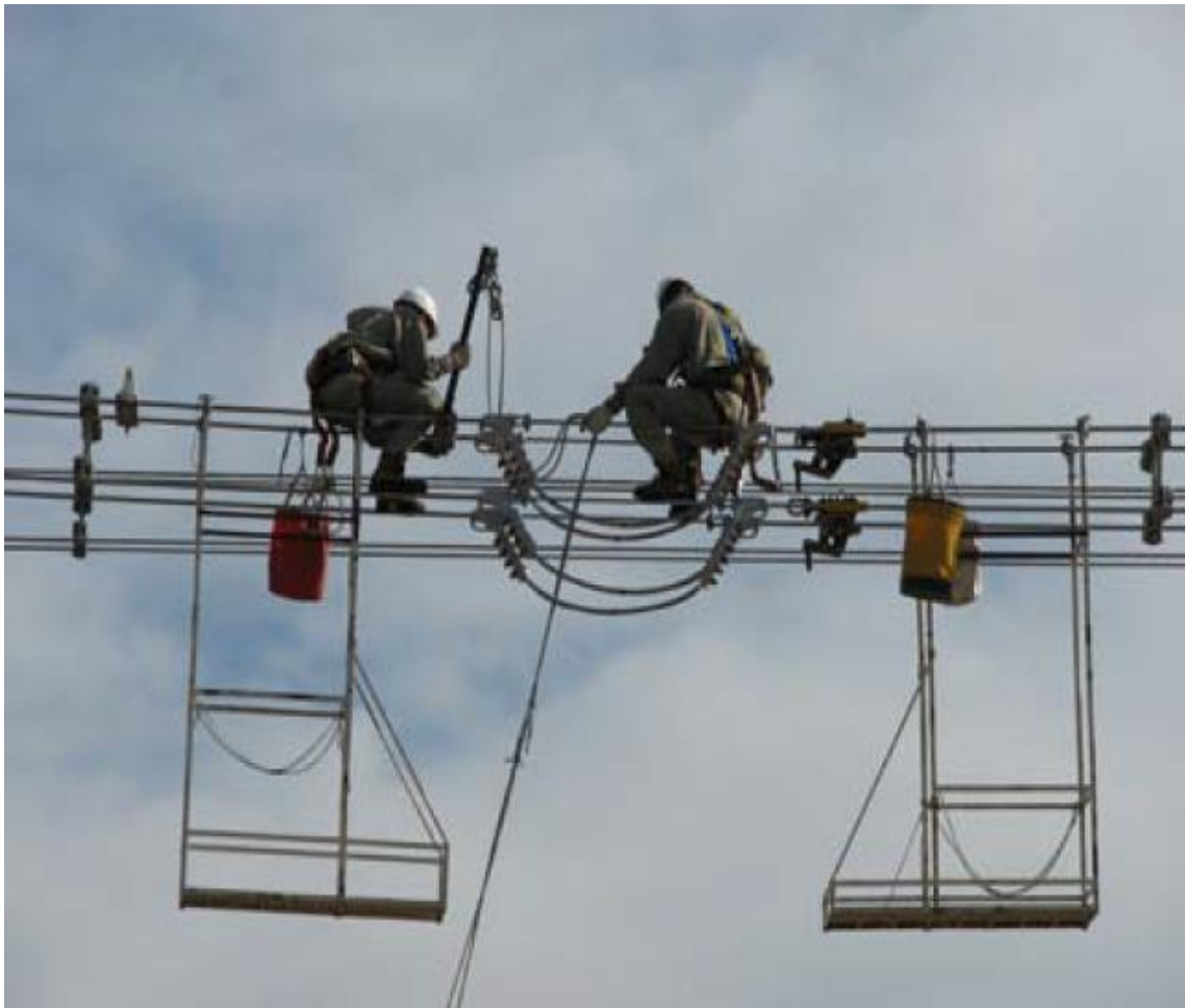
Sl. 3.9. Podešavanje provjesa vodiča na prijenosnom nadzemnom vodu [5].
