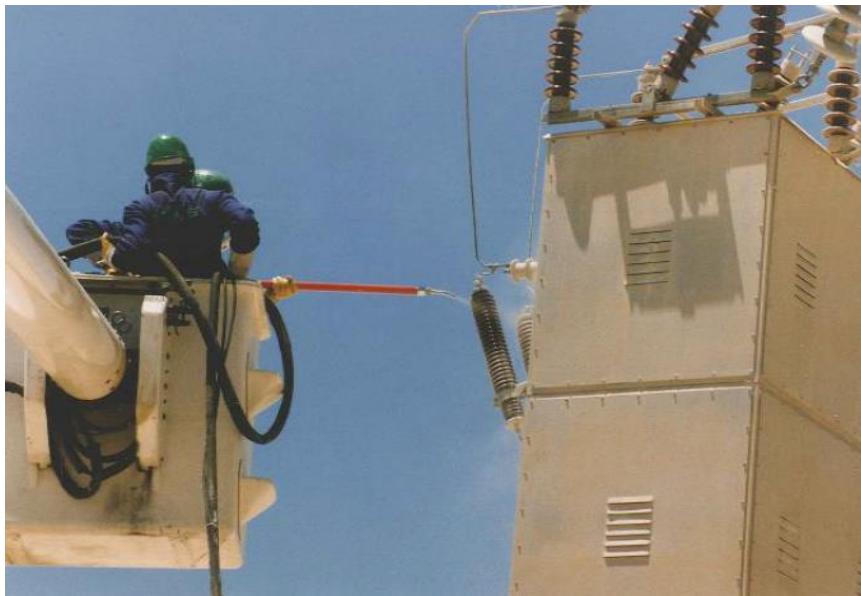
Sl. 3.21. Čišćenje pomoću čestica ljuski oraha, lješnjaka, riže i gipsa (žbuke) [12].
