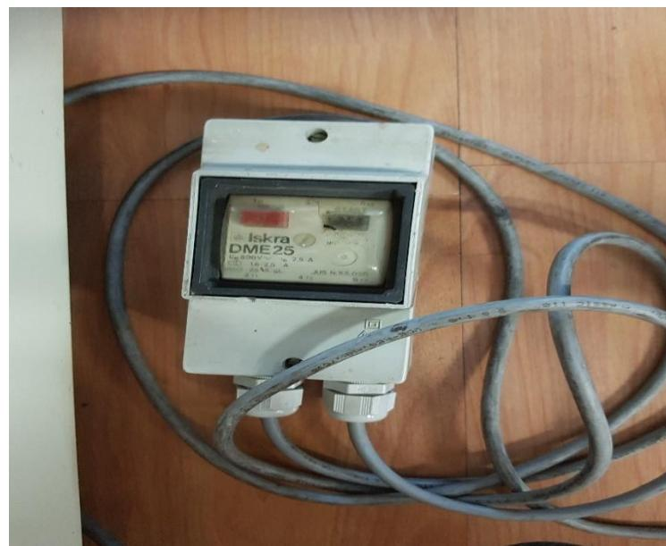
**Slika 3.9.** Motorna zaštitna sklopka Iskra DME 25.
