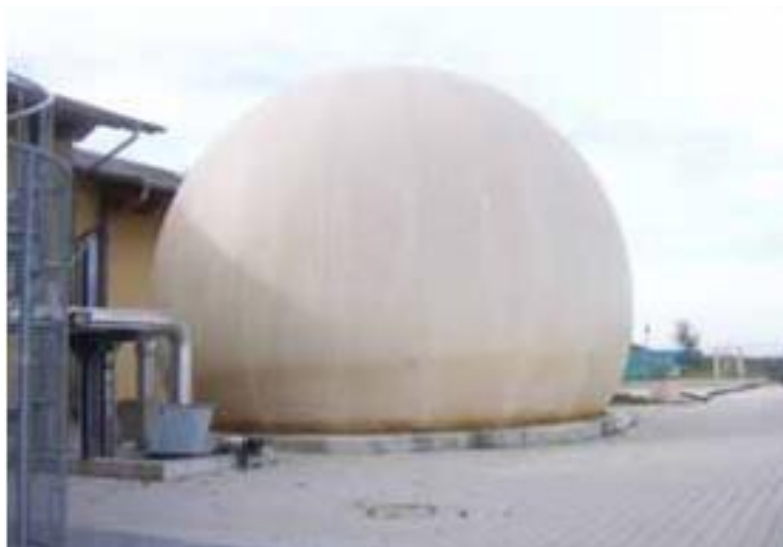
Slika 3.6. Skladište bioplina [1]
