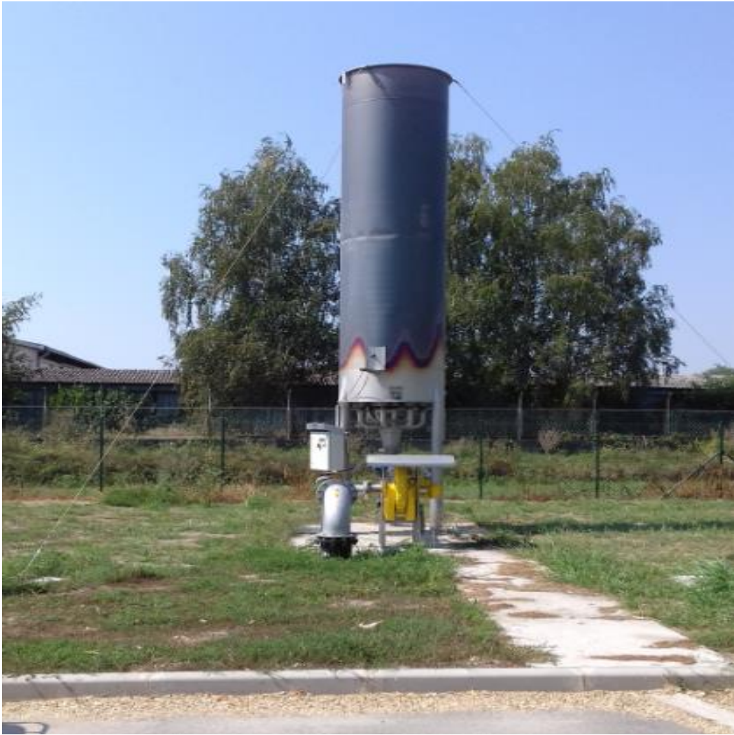
Slika 3.7. Baklja za spaljivanje bioplina [fotografirano 23.8.2018. u Osijeku]
