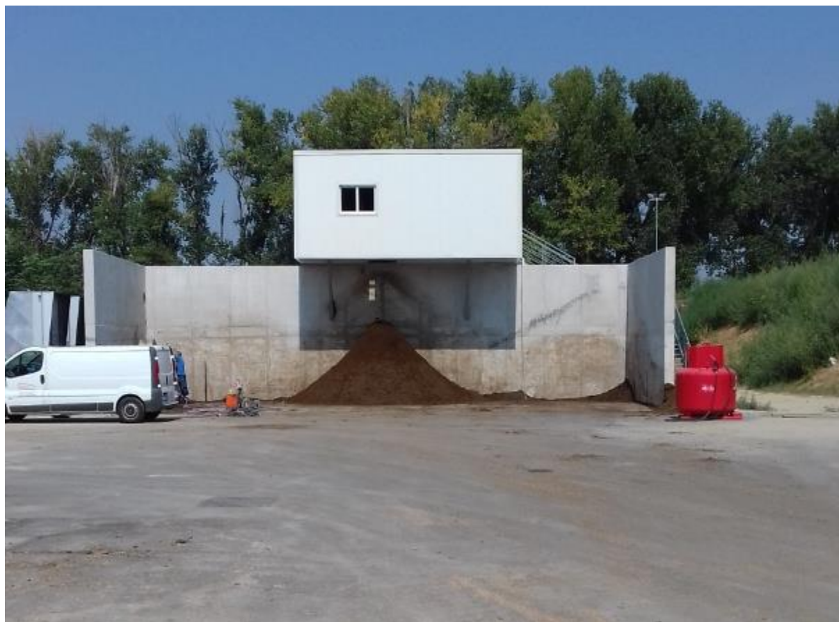
Slika 3.8. Separator digestata [fotografirano 23.8.2018. u Osijeku]
