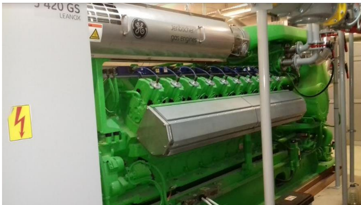
Slika 3.9. Plinski Otto motor Jenbacher J 420 GS u bioplinskom postrojenju Klisa [fotografirano 23.8.2018. u Osijeku]
