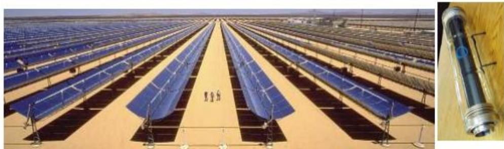
**Slika 3.1. Izgled parabolične protočne solarne termoelektrane [4]**
