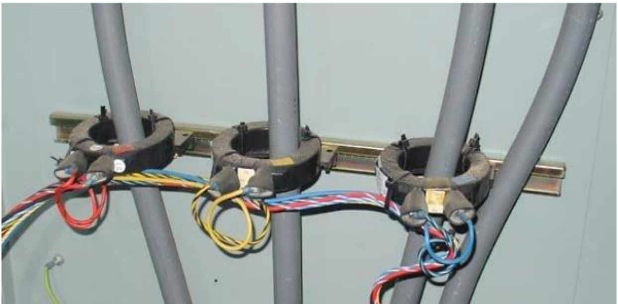
Slika 3.1: Primjer jednostavne izvedbe NN provlačnog strujnog mjernog transformatora [6]
