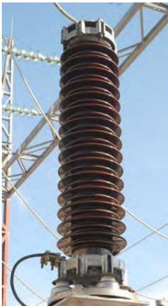
Slika 2.4: Izgled ZnO odvodnika [4]
