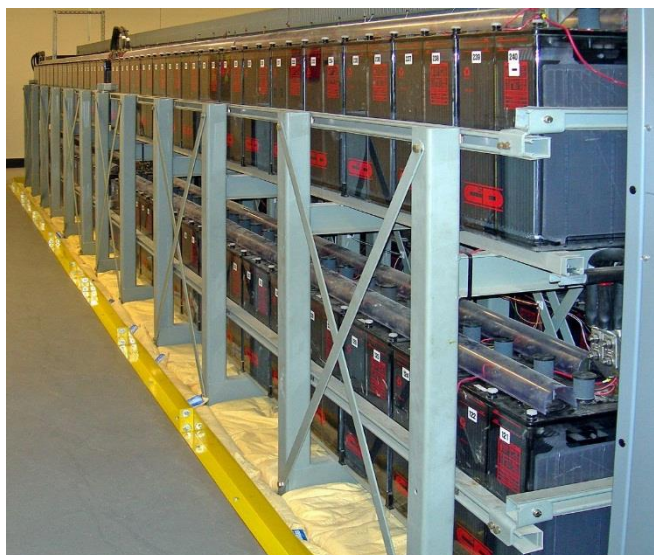
Slika 3.1. Primjer baterijskih spremnika
