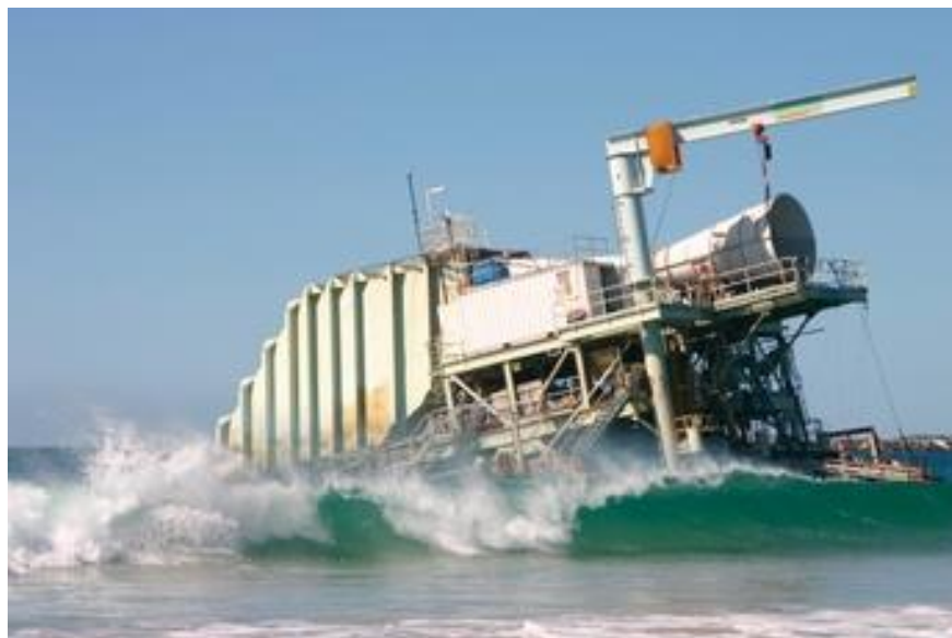
Sl. 3.11. 500 kW postrojenje, Australija [19]
