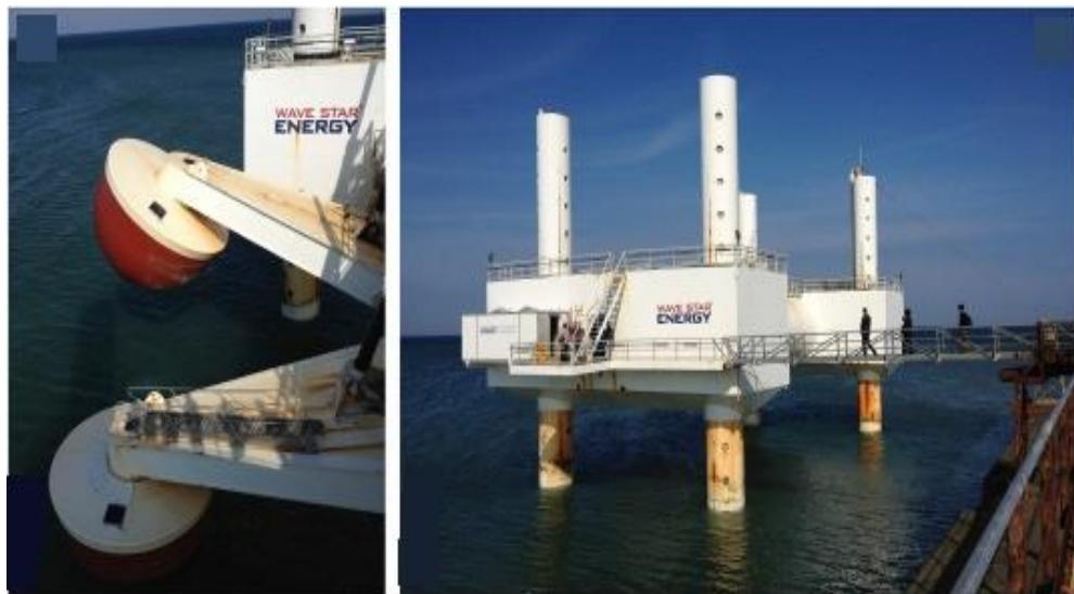
**Sl. 3.31.** Prototip Wave Star-a testiran u Danskoj 2009.
