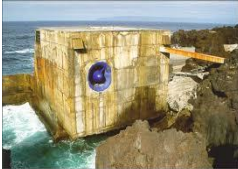
Sl. 3.8. 400 kW postrojenje na otoku Pico, Portugal [16]
