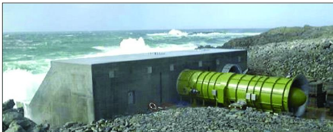
Sl. 3.9. 500 kW postrojenje LIMPET, otok Islay, Škotska [17]
