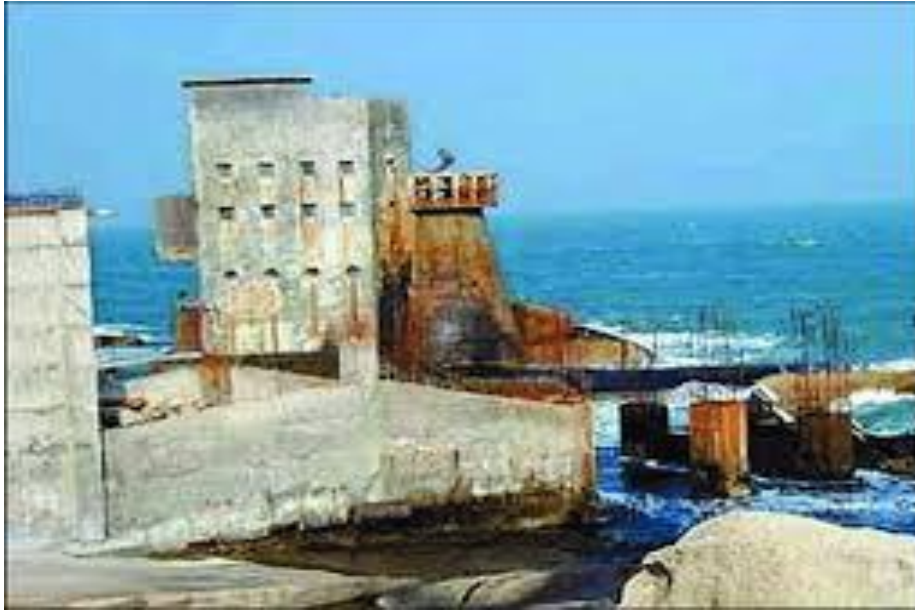
Sl. 3.10. 100 kW postrojenje, Guangdong, Kina [18]
