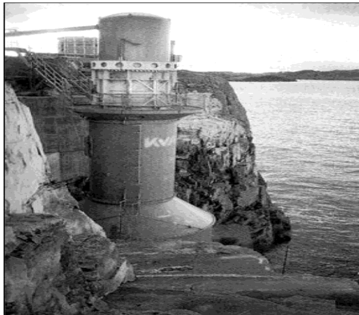
Sl. 3.3. Prototip elektrane na obali u Toftestallenu [10]
