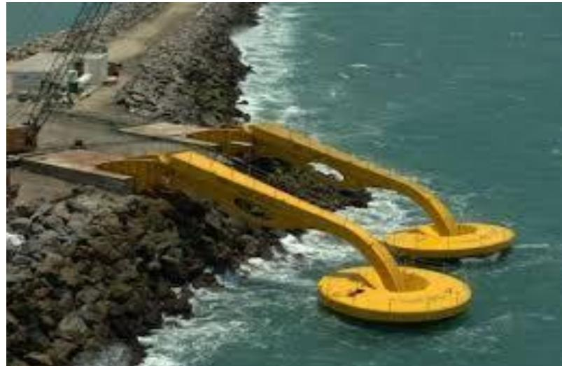
**Sl. 3.32.** Dvodijelni prototip hiperbaričnog uređaja instaliranog u lukobran, Brazil
