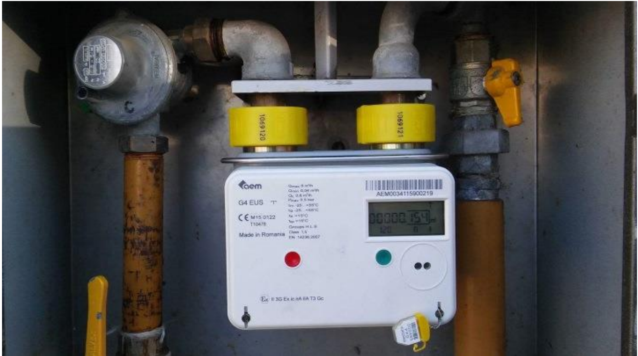
Slika 4.10. Ultrazvučni plinomjer G4EUS V1 [Izvor: tvrtka u suradnji]
