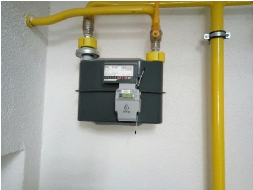
Slika 4.7. Modul s koncentratorom OXO X373 [Izvor: tvrtka u suradnji]
