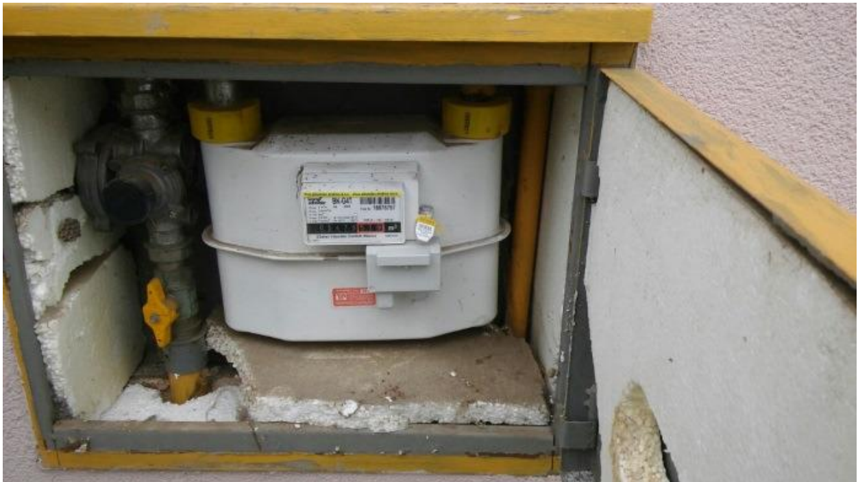
Slika 4.8. Modul Wireless M-Bus GasPulsar [Izvor: tvrtka u suradnji]
