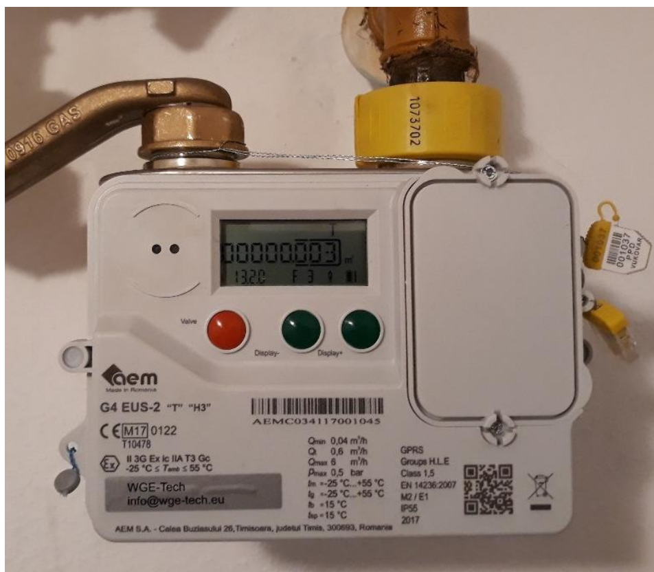
Slika 4.11. Ultrazvučni plinomjer G4EUS V2 [Izvor: tvrtka u suradnji]
