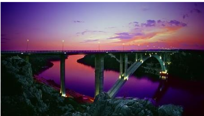
Slika 5.2. Prikaz stupova javne rasvjete
