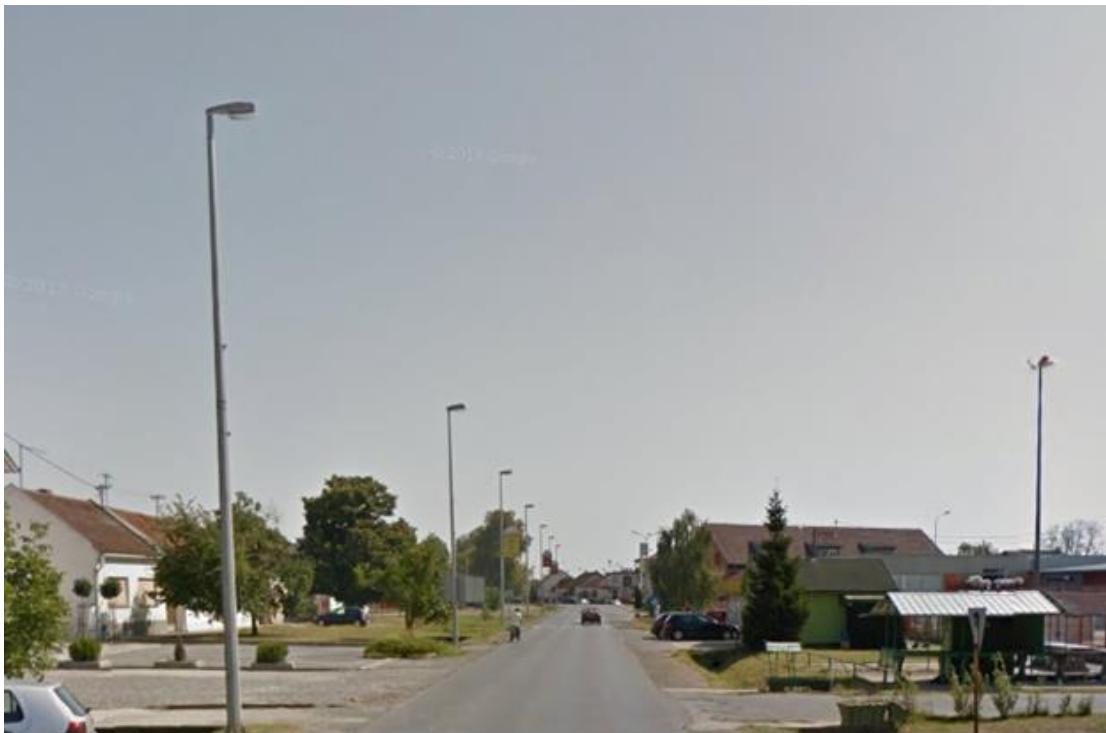
Slika 3.5 Postojeće svjetiljke ulica Kralja Zvonimira
