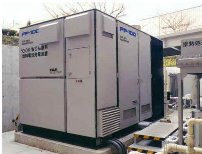
Slika 2.6: Gorivna ćelija s fosfornom kiselinom [3]
