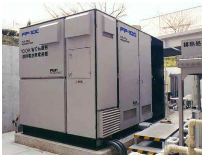
Slika 2.6: Gorivna ćelija s fosfornom kiselinom [3]
