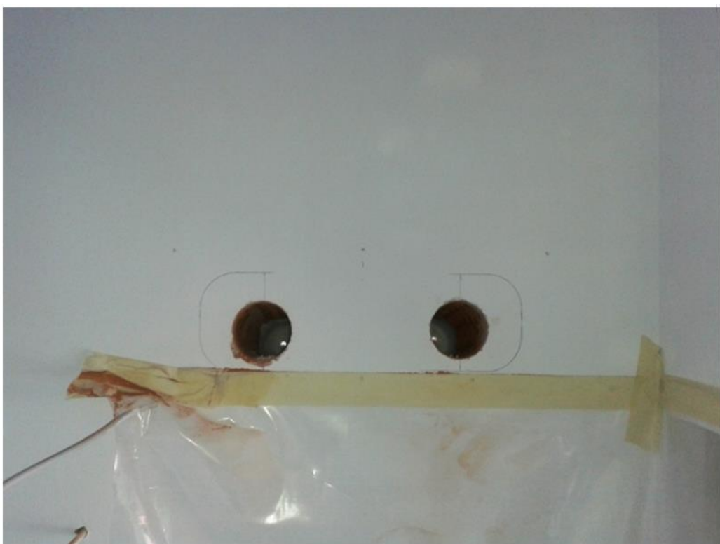
Slika 3.23 Bušenje usisnog i odsisnog ventilacijskog kanala
