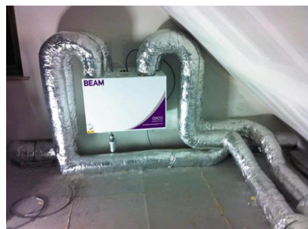
Slika 3.15 Četiri odvojena kanala za zrak[14]
