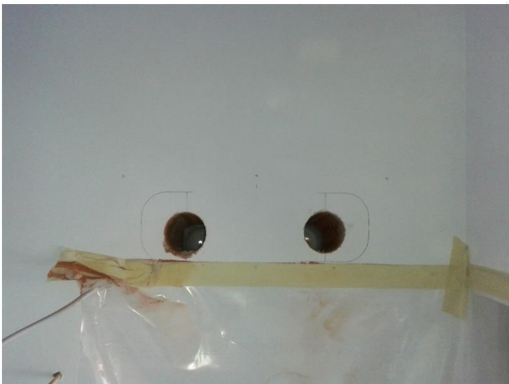
Slika 3.23 Bušenje usisnog i odsisnog ventilacijskog kanala
