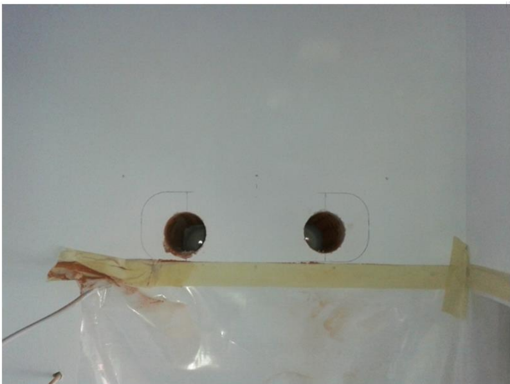
Slika 3.23 Bušenje usisnog i odsisnog ventilacijskog kanala
