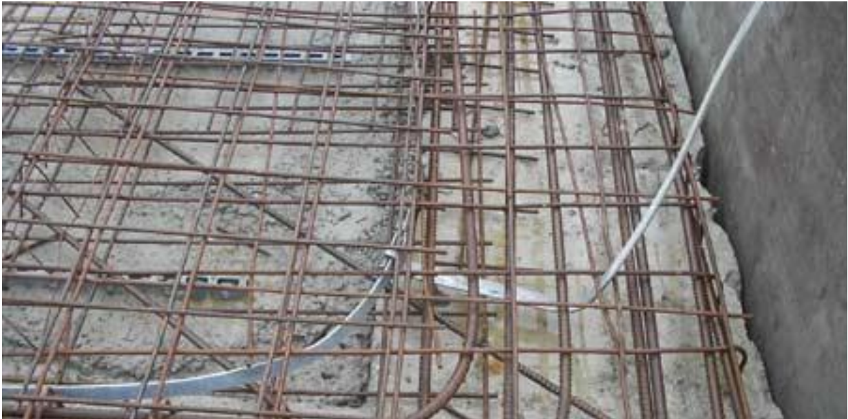
Slika 2.13 Temeljni uzemljivač[7]
