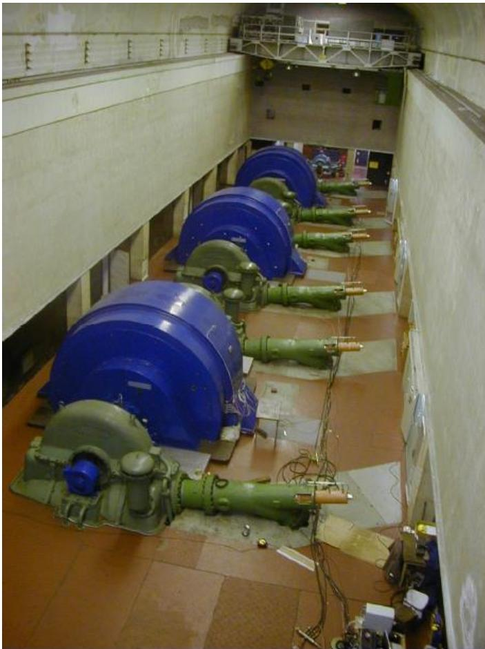
**Slika 2.7.** Agregati s po dvije turbine instalirane snage 15,75MW[1]
