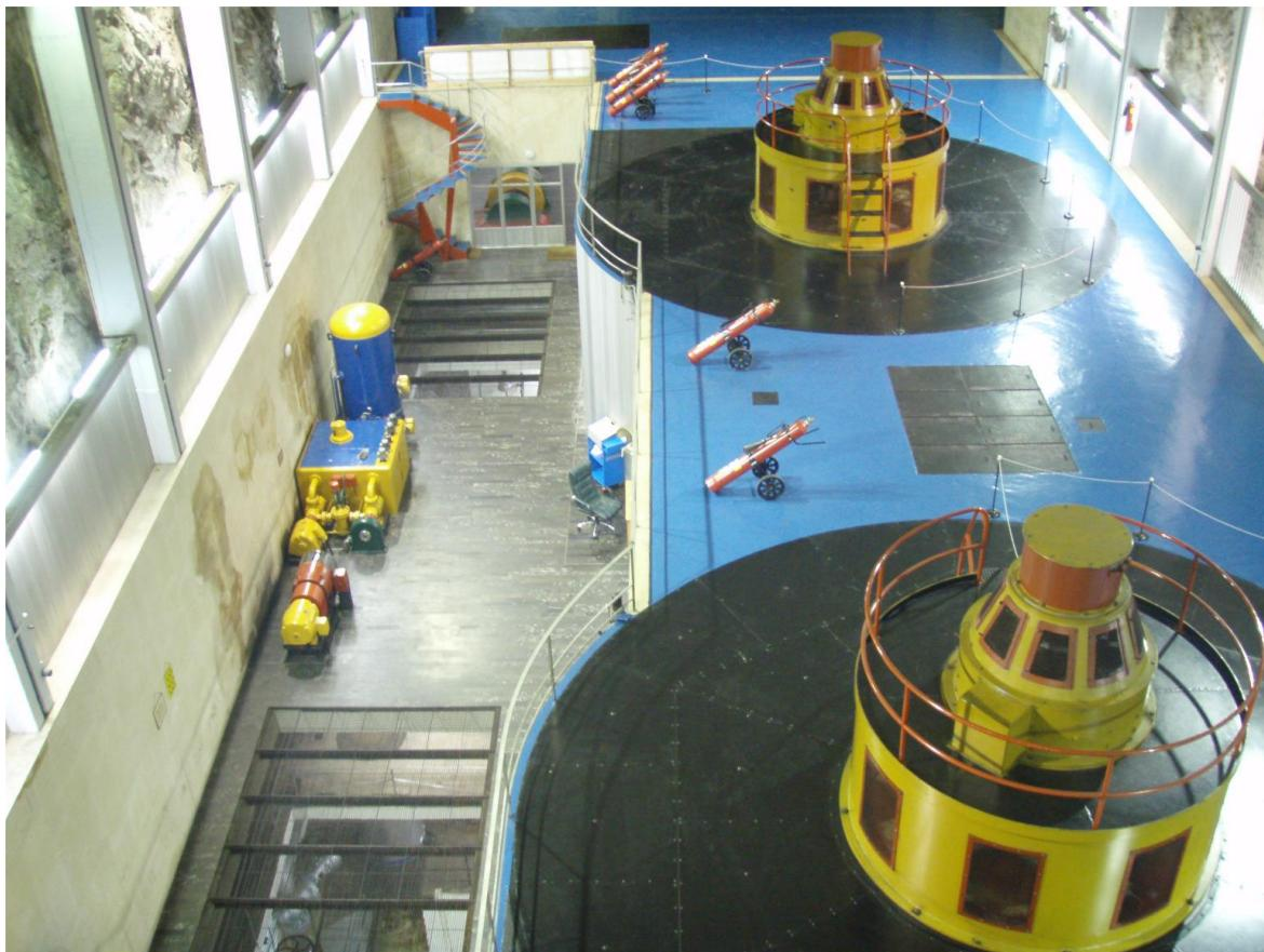
**Slika 2.3.** Fotografija sinkronih generatora 108 kV u HE Dubrovnik[1]
