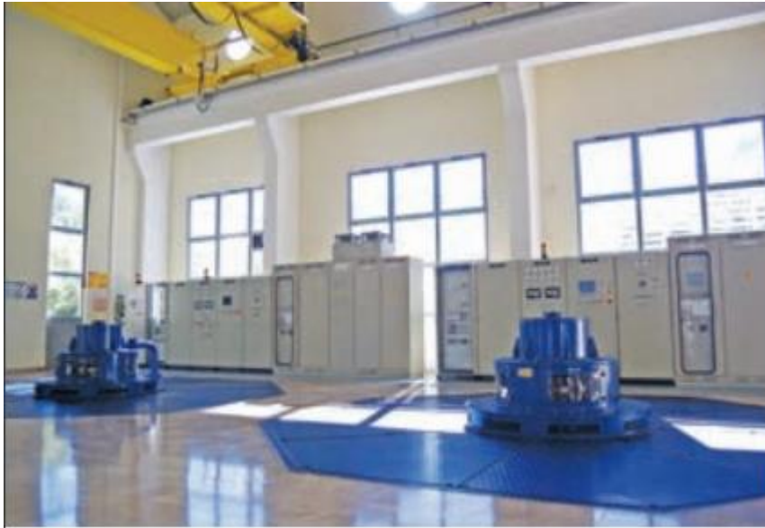
Slika 2.10. Trofazni sinkroni generatori KONČAR 18MWA[8]
