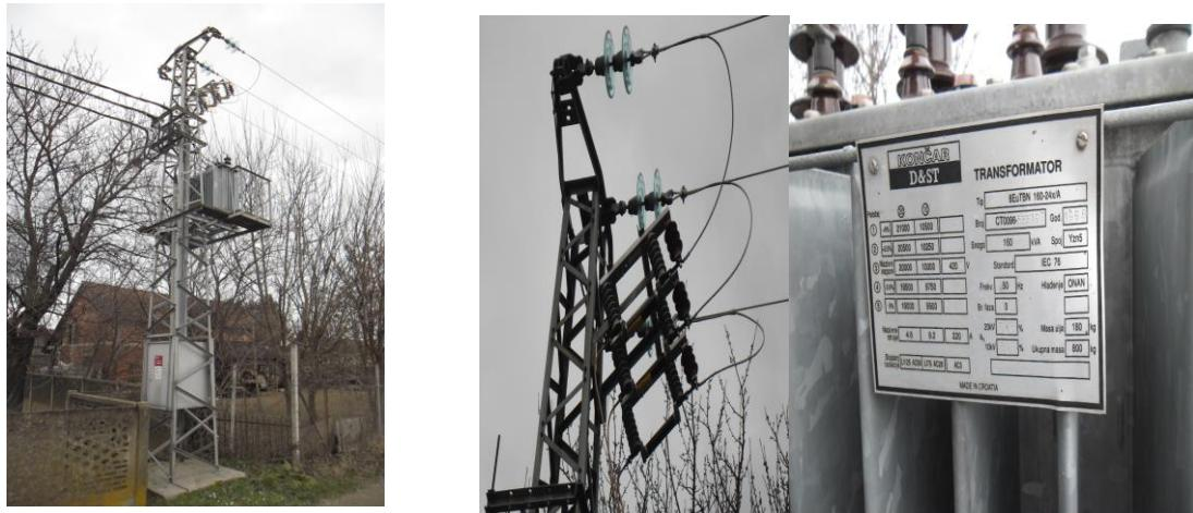
*Sl.4.2.Željezna trafostanica sa visokonaponskim osiguračima i transformatorom*
