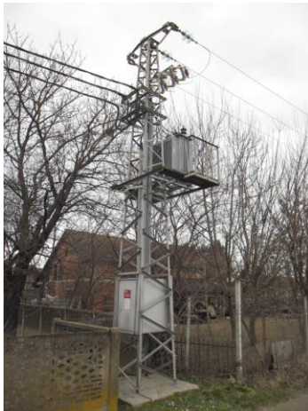
Sl.4.2.Željezna trafostanica sa visokonaponskim osiguračima i transformatorom
