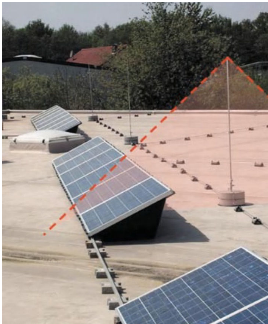
Slika 4.6. Zaštita FN sustava s hvataljkama [8].
