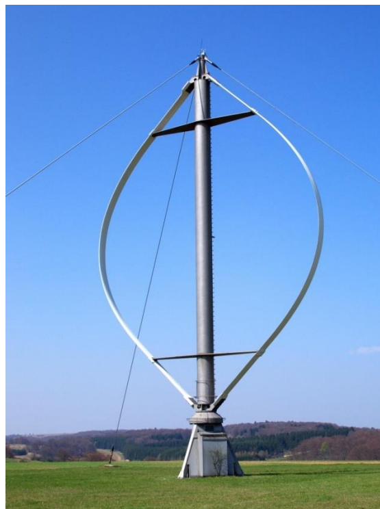
Slika 3.21. Darriuesov tip vjetroelektrane [28]
