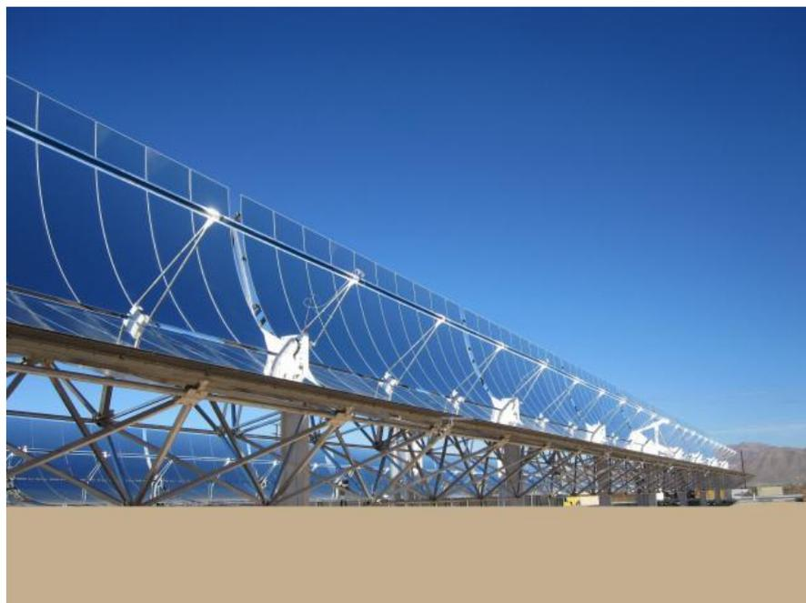
*Slika 3.18. Parabolični kolektori[22]*
