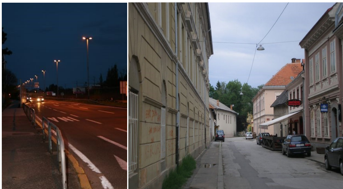
Slika 4.10. Rasvjeta poslijerealizacije projekta energetske učinkovitosti javne rasvjete u gradu Karlovcu [8]
