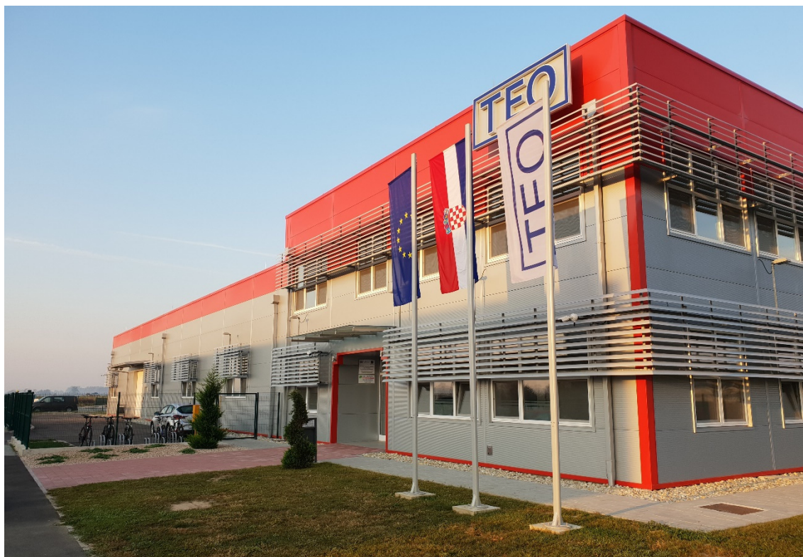
Slika 3.12. Zgrada koja je korištena u istraživanju
