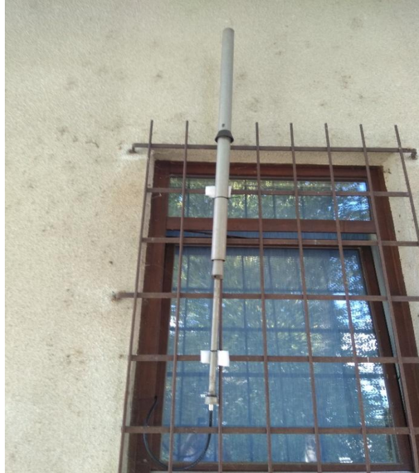
Slika 4.3. Monopol antena
