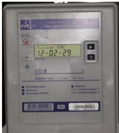
Slika 3.6. Prikaz trofaznog četverotarifnog brojila proizvođača Riz
