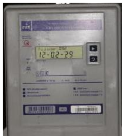
Slika 3.6. Prikaz trofaznog četverotarifnog brojila proizvođača Riz
