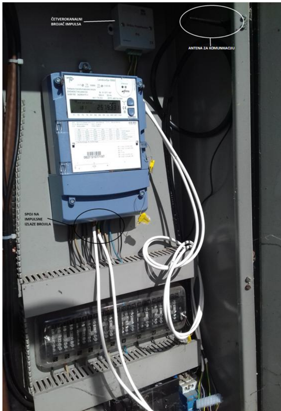
Slika 4.8. Spajanje na brojilo
