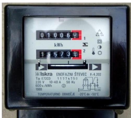
Slika 3.5. Prikaz jednofaznog dvotarifnog brojila proizvođača Iskra
