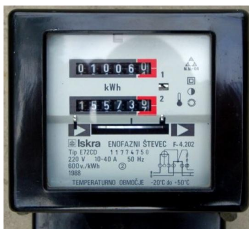
Slika 3.5. Prikaz jednofaznog dvotarifnog brojila proizvođača Iskra
