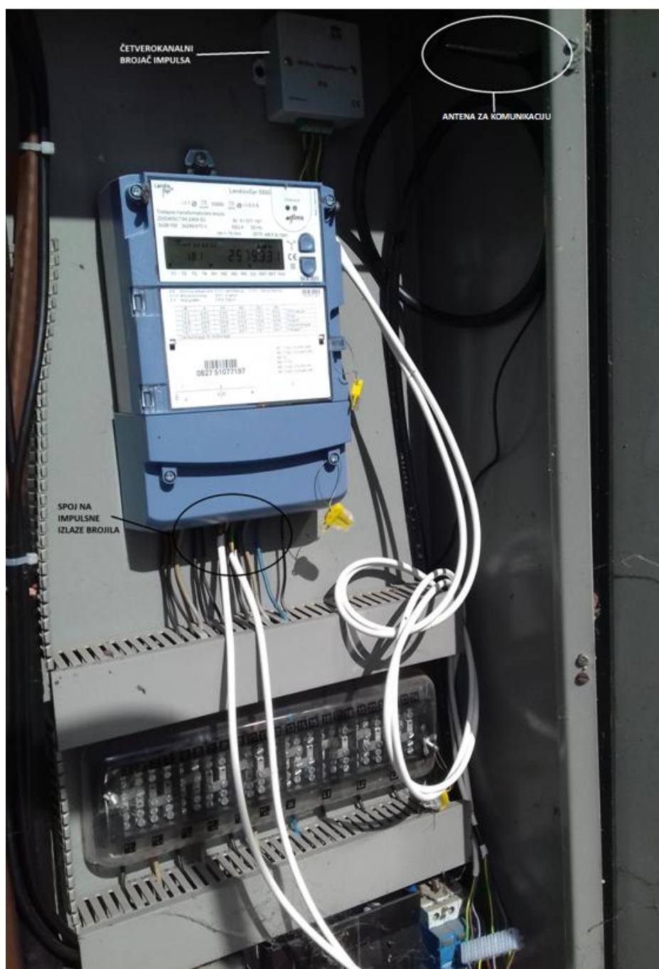
Slika 4.8. Spajanje na brojilo
