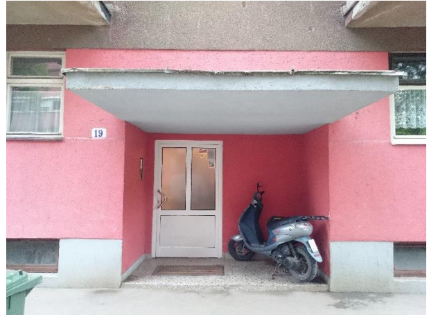
Slika 4.20. Ulazna vrata zgrade PVC-PVC.
