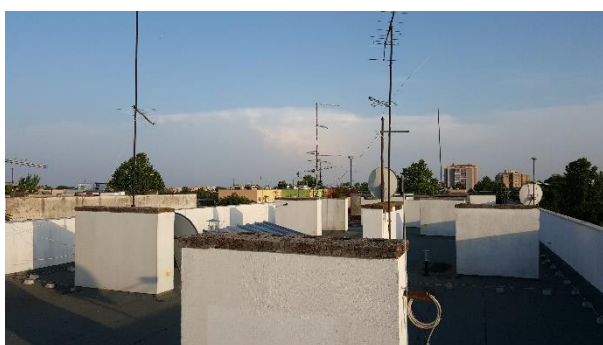
Slika 4.7. Ravni krov zgrade.
