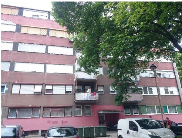
Slika 4.3. Istočno pročelje zgrade.
