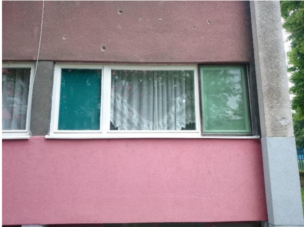
Slika 4.19. Karakteristični otvor zgrade D-KNK (prozor stambenog prostora).
