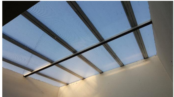
Slika 4.16. Karakteristični otvor zgrade M-JED (svjetlarnik stubišta).
