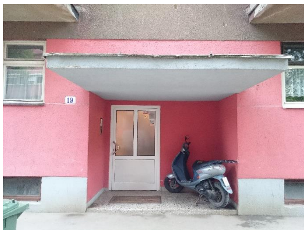
Slika 4.20. Ulazna vrata zgrade PVC-PVC.
