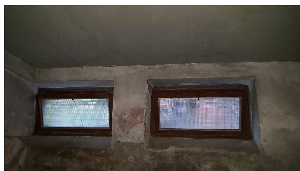
Slika 4.12. Karakteristični otvor zgrade M-JED (prozor podruma).
