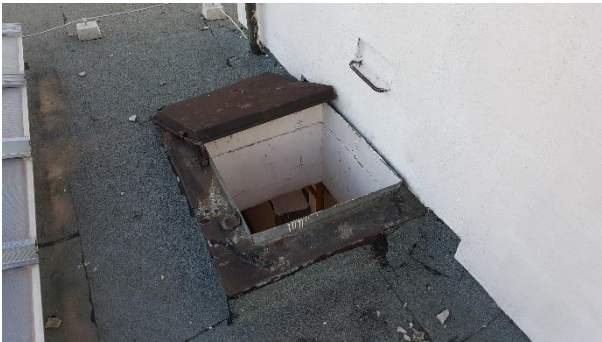
Slika 4.15. Karakteristični otvor zgrade M-M (izlaz na krov zgrade).
