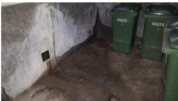
Slika 4.11. Pod podruma zgrade.
