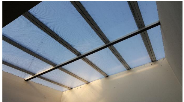
Slika 4.16. Karakteristični otvor zgrade M-JED (svjetlarnik stubišta).
