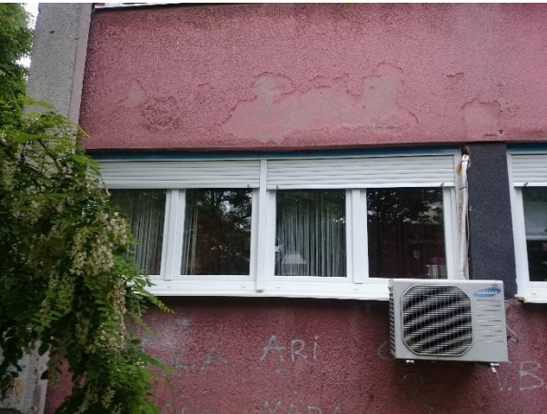
Slika 4.17. Karakteristični otvor zgrade PVC-IZO (prozor stambenog prostora).
