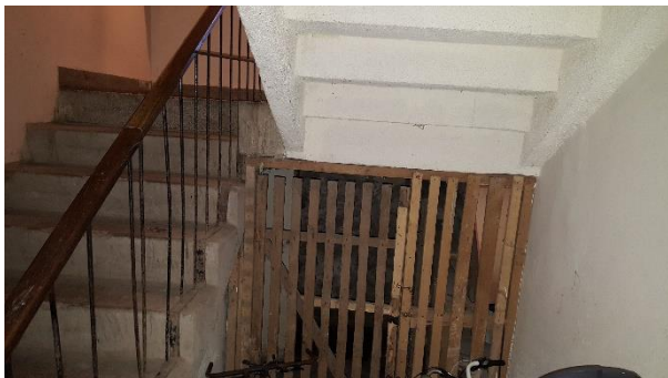
Slika 4.9. Stubište zgrade prema podrumu.
