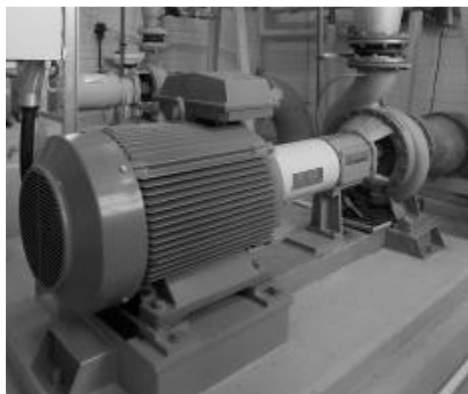
Slika 3.1. Centrifugalna crpka: najčešći tip crpke u industriji i komunalne usluge,[1]
