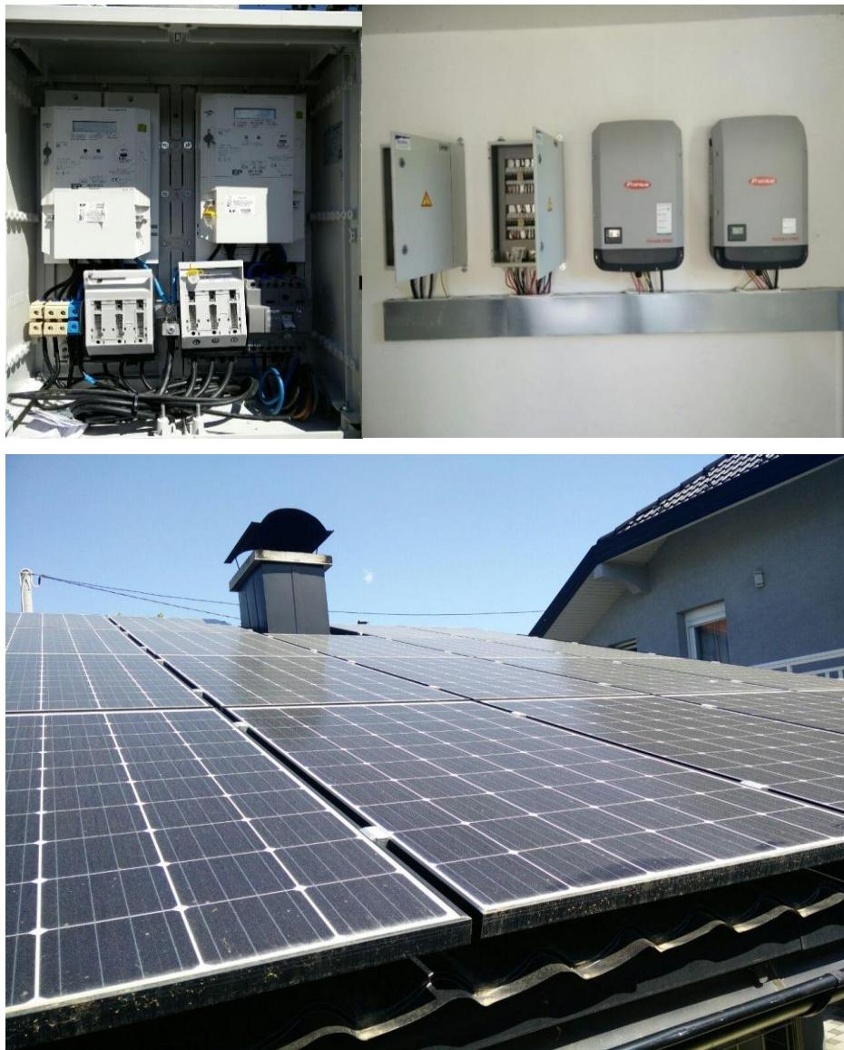
Slika 7.2. foto naponsko postrojenje i priključak na distribucijskoj mreži. Gore lijevo: AC ormari na stupu s mjernom i zaštitnom opremom. Gore desno: DC ormarić i izmjenjivači 2x10 kW.
