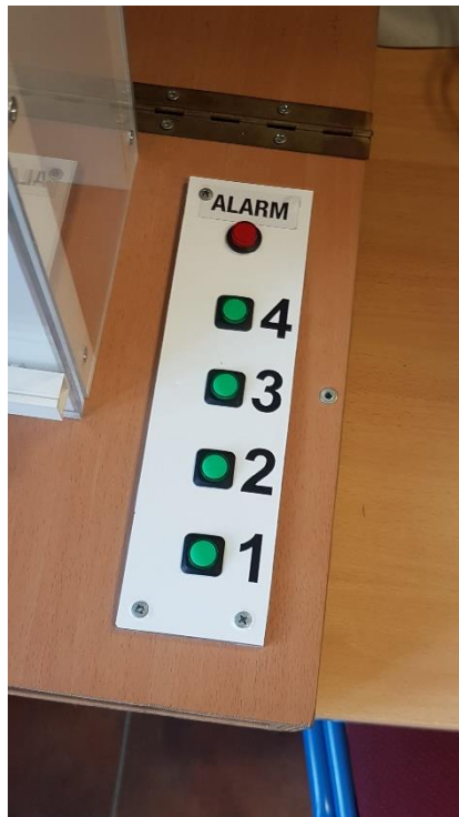
Slika 3.14. Upravljačka ploča makete dizala
