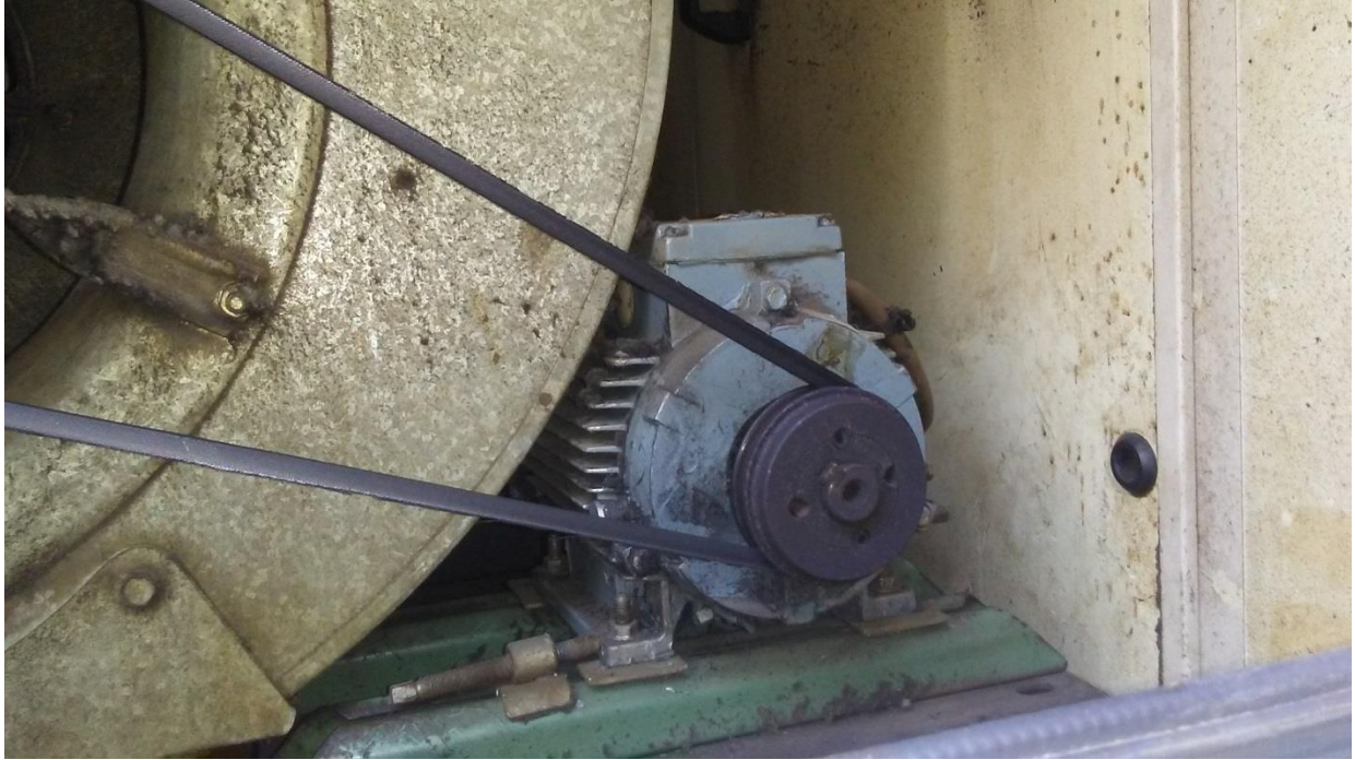
Slika 8.1 Asinkroni motor IE2 standarda
