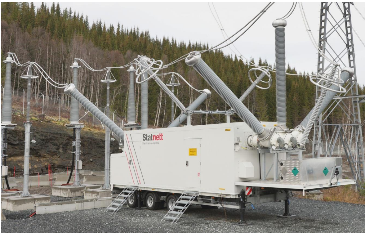
Slika 8.4 Mobilni GIS tvrtke ABB. [6]
