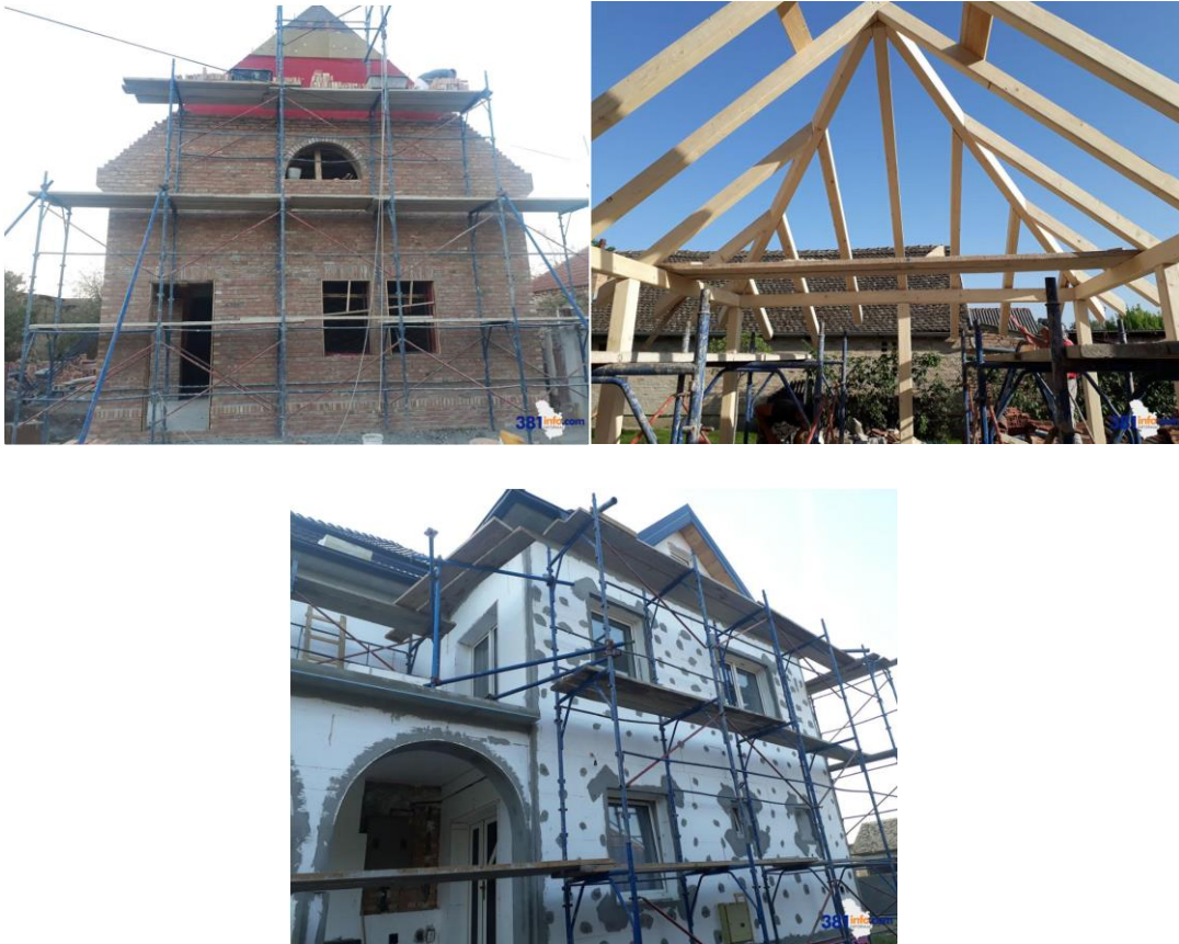
Sl. 5.3.2.1. Fotodokumentacija građevinskih radova, [24]
