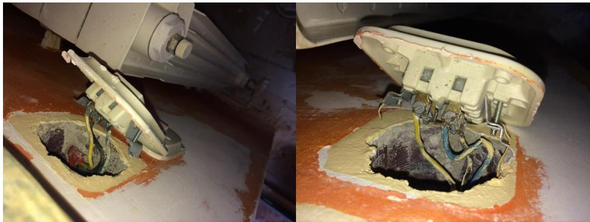
**Sl. 5.3.3.1. Fotodokumentacija žica spojenih na prekidaču**
