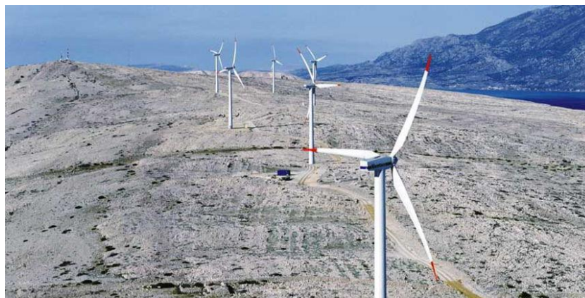
Slika 3.3. Vjetroelektrana Ravne 1 na Pagu [10]
