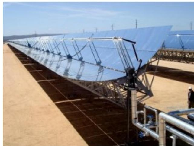
Slika 3.6. Postrojenje s paraboličnim žljebastim kolektorima [7]
