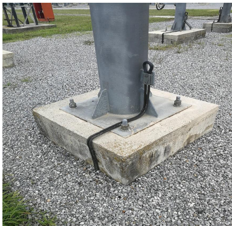
Slika 4.14. Uzemljenje stupa
