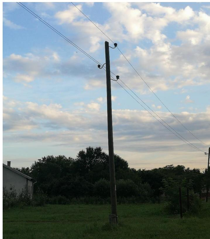
*Slika 4.12. 10(20) kV linijski drveni stup*
