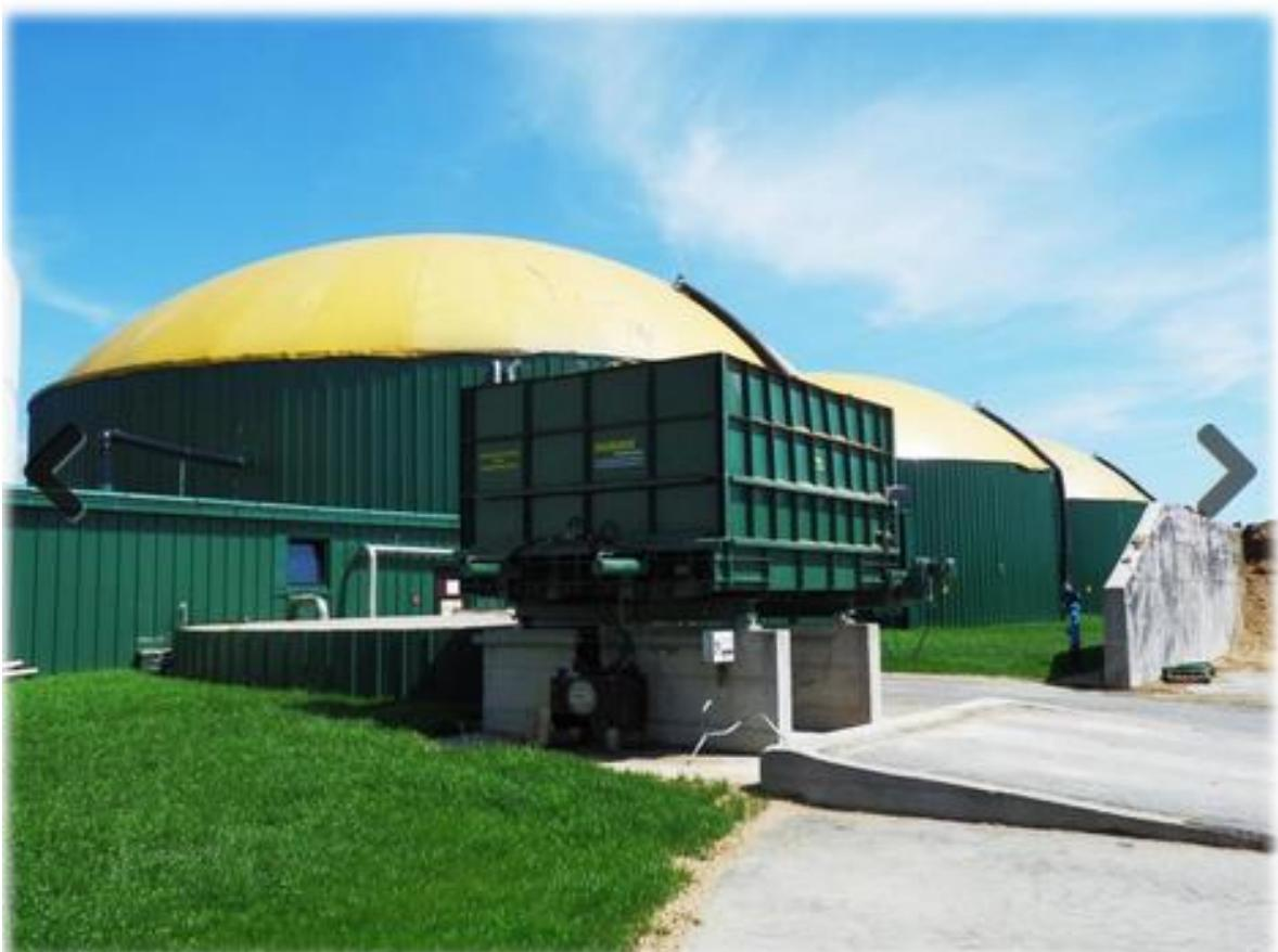
Slika 3.7. Bioplinsko postrojenje Ivanka u kojem se razgrađuje otpad anaerobnom digestijom [6]
