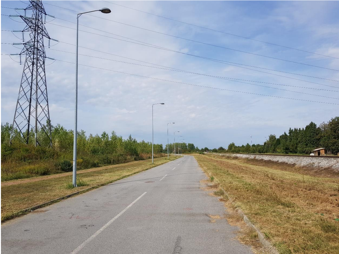
Slika 4.2. Jednostrani raspored svjetiljki sa SRS 2B stupovima.
