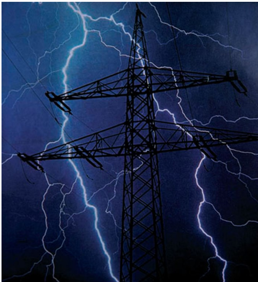
Slika 3.6. Udar groma u blizini dalekovoda [3]
