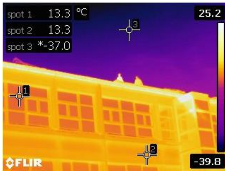
Sl.3.1. Primjer termograma zgrade
