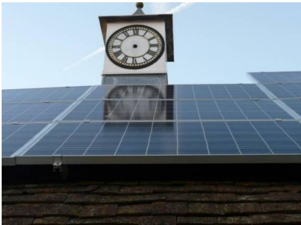
*Slika 3.11. Trajno zasjenjenje fotonaponskih modula[9]*
