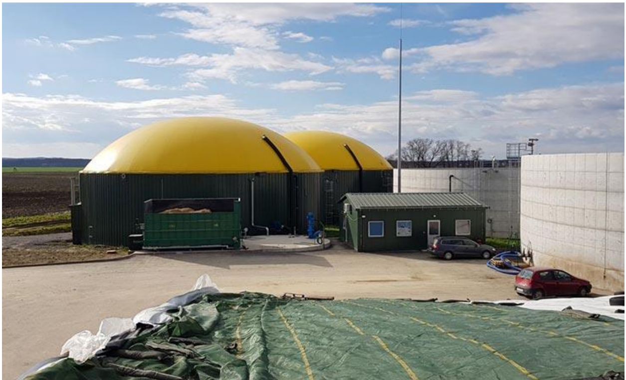
Slika 8. Bioplinsko postrojenje Orlovnjak
