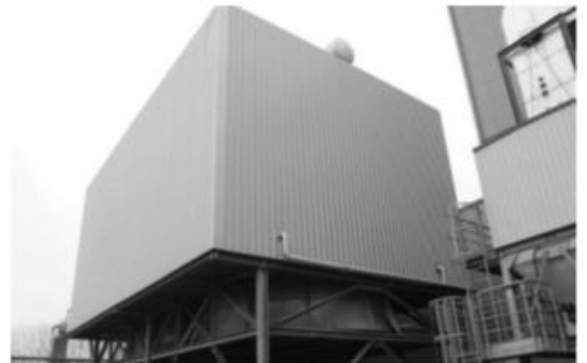
Zračni kondenzator
