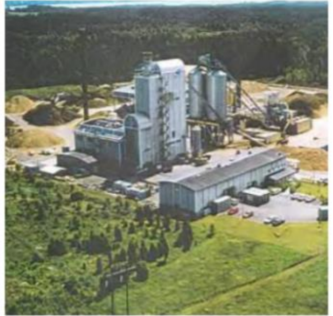
Finska kogeneracija VN, 49 (167) MW
