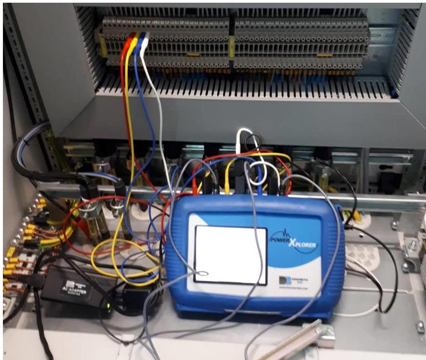
Slika 4. Spoj naponskih stezaljki u mjernom ormaru
