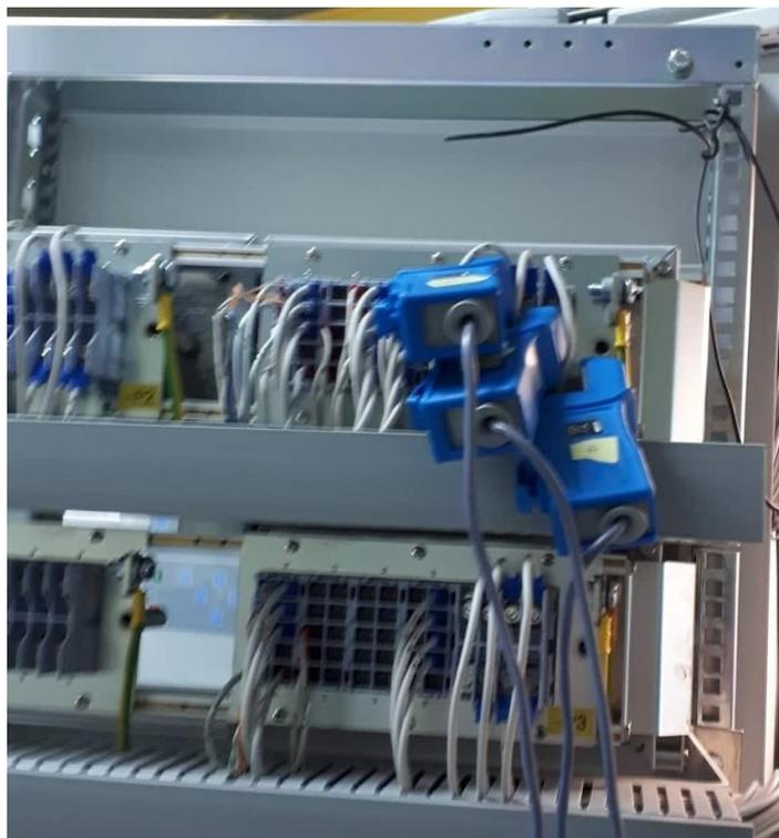
Slika 5. Spoj strujnih kliješta u strujnom ormaru
